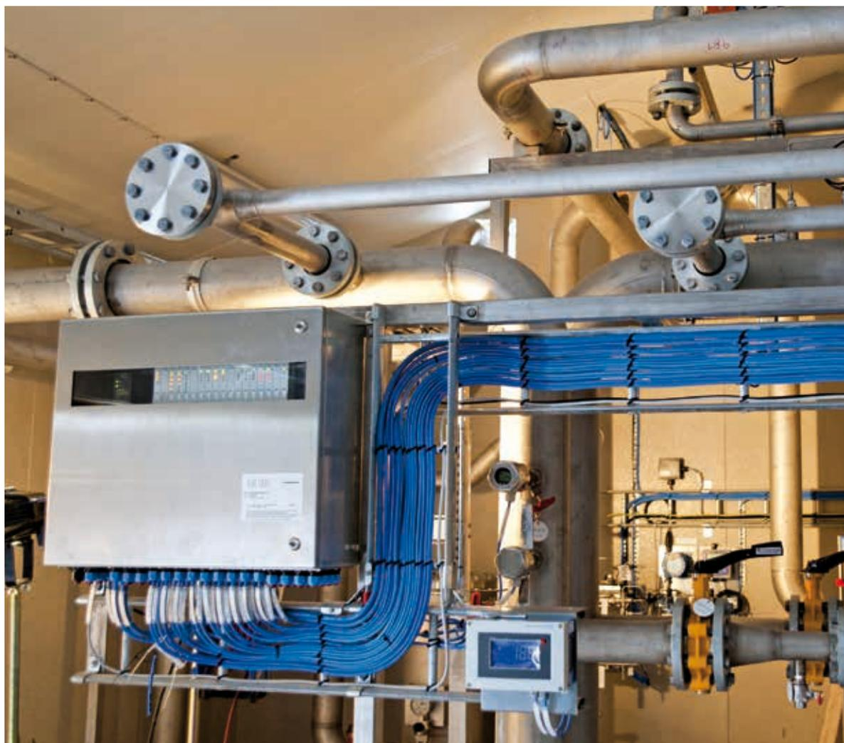
通过excom金属箱的窗口，压缩机室中的所有LED指示灯的状态都是直接可见的
