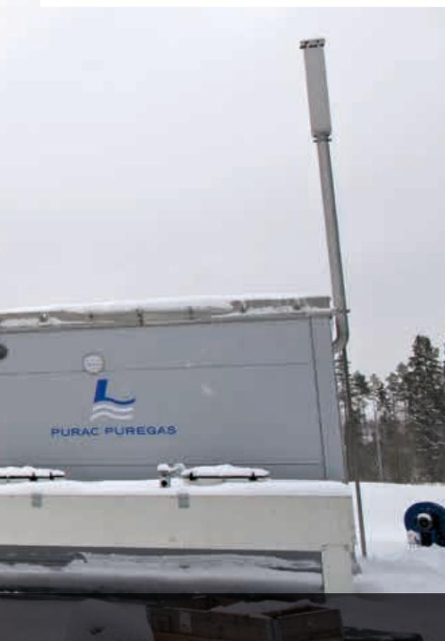
瑞典Läckeby Water Group通过其Purac Puregas天然气公司可提供沼气净化工厂服务。Purac Puregas天然气工厂可将原始沼气净化成几乎纯净的生物甲烷气。利用CApure化学吸收工艺，工厂可从原始沼气中去除二氧化碳与硫化氢(H<sub>2</sub>S)，该法提高了沼气工厂的效率，并可改善其生态平衡。该系统可保证原始沼气中99.9%的甲烷净化为生物甲烷气以便于商业利用。对于大型的自然垃圾处理器来说，如当地的垃圾管理企业，沼气是一种非常有用的可再生能源。
