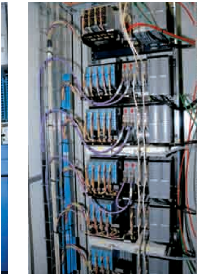
横河Centum VP控制系统的冗余Profibus 总线连接提高了系统的可用性。
