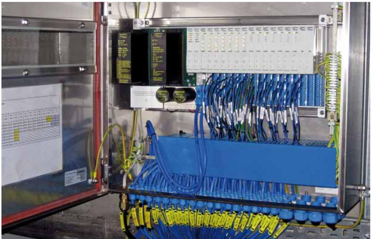
高通道密度：除冗余电源外，excom模块机架最多可承载128个开关量或64个模拟量输入/输出信号
