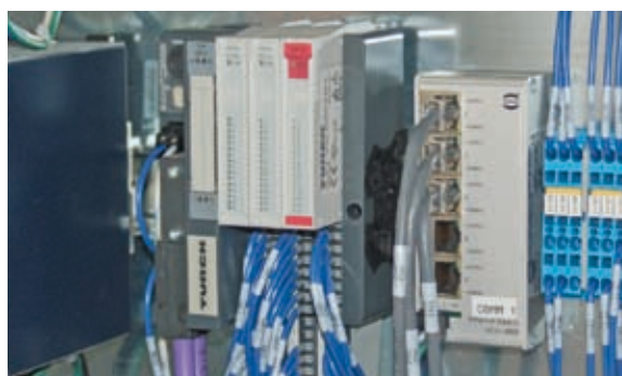
BL20 I/O模块的安装用于控制和诊断设备
