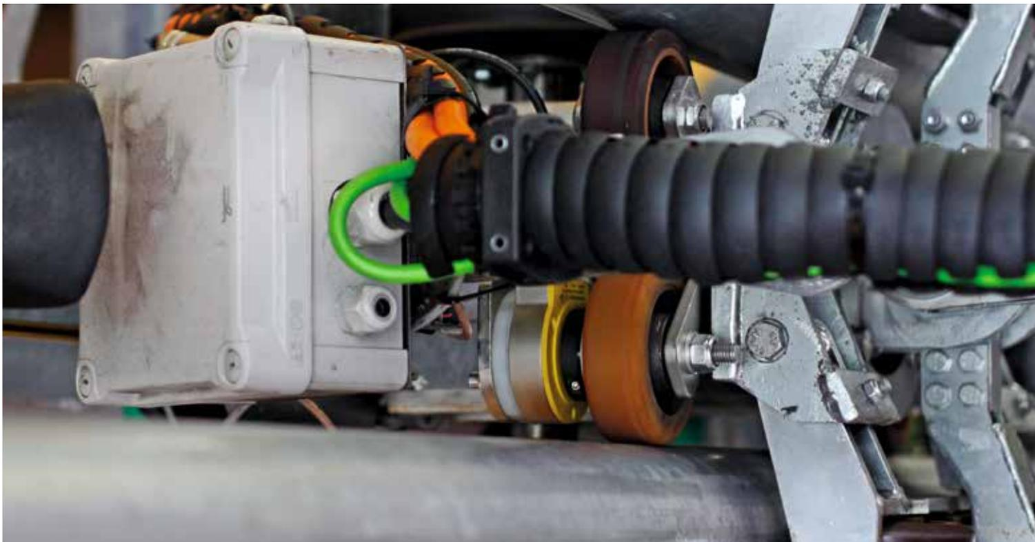
图尔克的QR24-INCR编码器被安装在导轨的滚轮上，并在这里向控制器发送脉冲信号
