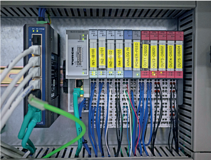
中央BL20 I/O工作站位于中央润滑设备，并通过Profinet将所有信号转发至TX513 HMI
