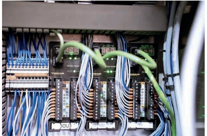
图尔克的FEN20设备可以使控制台的开关信号通过总线传输
