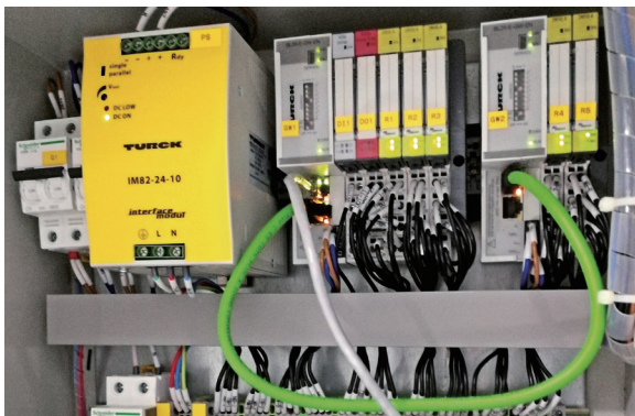
图尔克BL20 RFID和I/O系统确保了与PLC的可靠通讯
