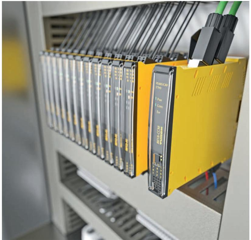
图尔克的IM18-CCM控制柜保护模块可通过以太网将测量值传输至IT网络，并且甚至可以预先对其进行远程预处理
