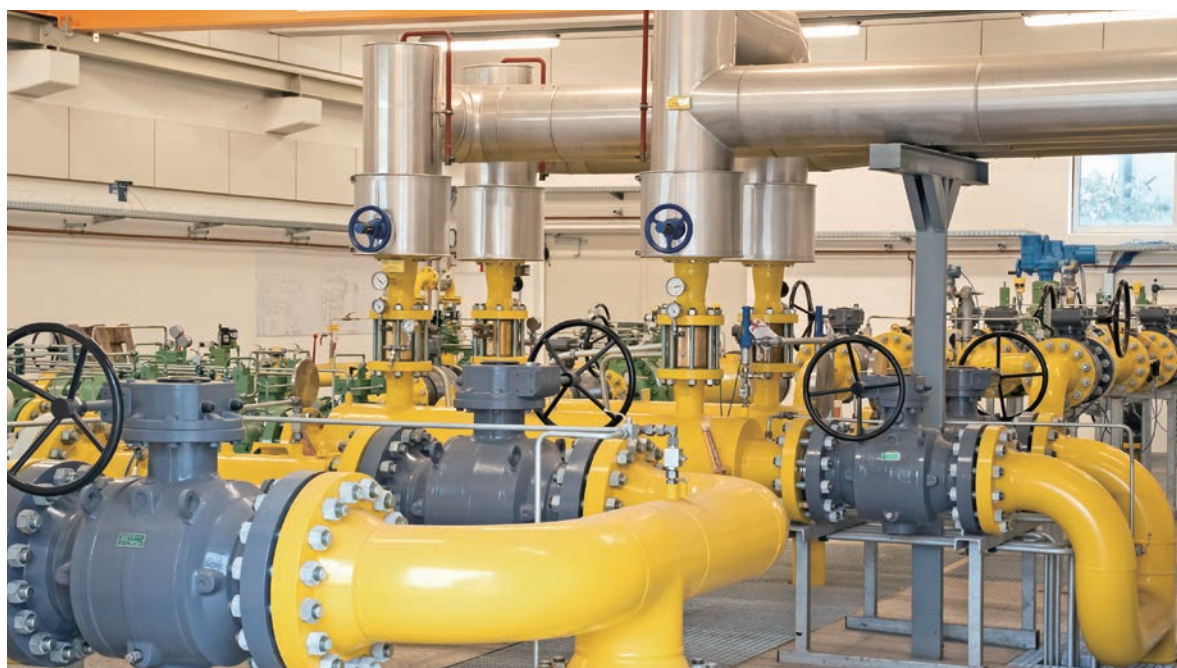
在输气站，e-netz Südhessen AG按照当地管路的情况对供应的天然气进行调整
