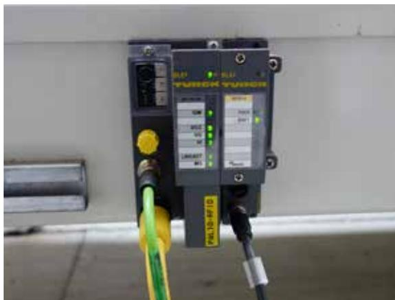
现场安装的网关和RFID接口模块
