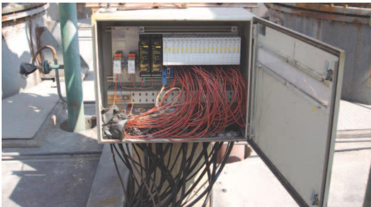
excom远程I/O系统由电源模块、网关、I/O模块和机架组成，可以配置为使用24V DC或230V AC电压
