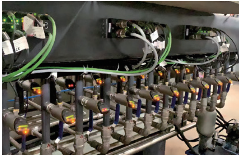
传感器外壳可340°自由旋转，便于调整显示器和电气连接
