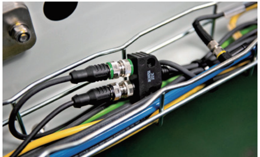
M12连接采用彩色编码实现防呆设计，可保证快速且准确的布线
