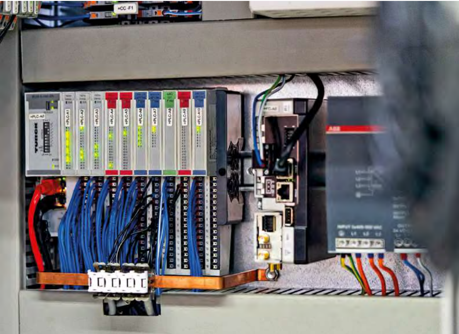
压力变送器提供的测量数据将发送至BL20 I/O系统
