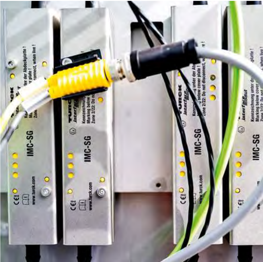
因为采用TB-SG不锈钢保护外壳，所以几乎所有TBEN I/O模块都获批用于ATEX 2区
