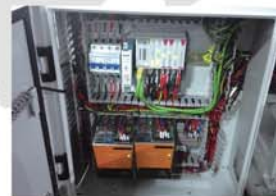
⑮ 总线电器控制，收集现场设备信号，用于电器控制
