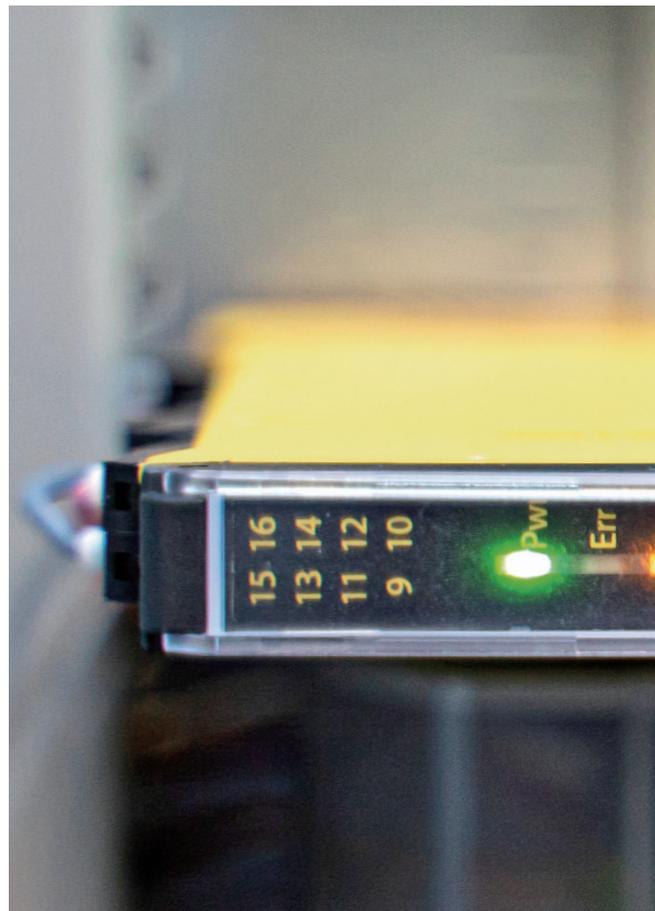
达姆施塔特 (Darstadt) 的公司对各个分散设施中的控制柜进行状态监测，例如输气站或沼气工厂等。在这些地方，图尔克的 IM12-CCM 控制柜保护模块可以检测柜门是否打开或温度是否过高。
