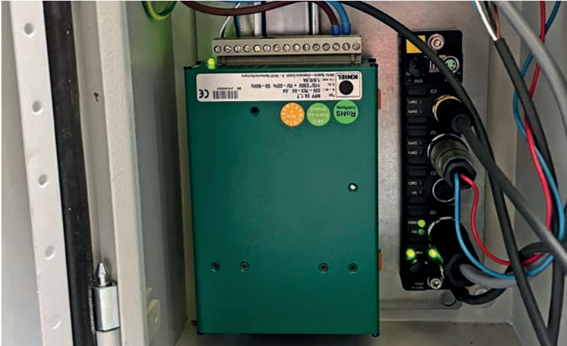
采用图尔克AGREE逻辑软件编程的TBEN-S模块持续发送检测机器人的读取请求
