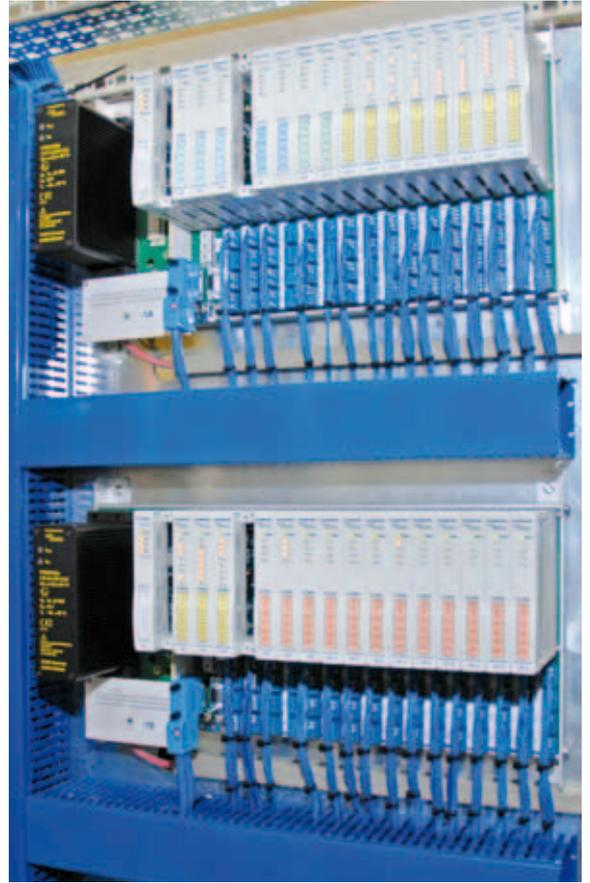
仅仅用了个周末，EAB自动化就已经将新的excom系统安装到了19英寸机架中
