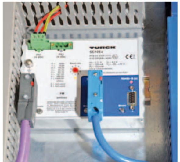
SC12Ex段耦合器用于RS485和RS485-IS的本安型隔离
