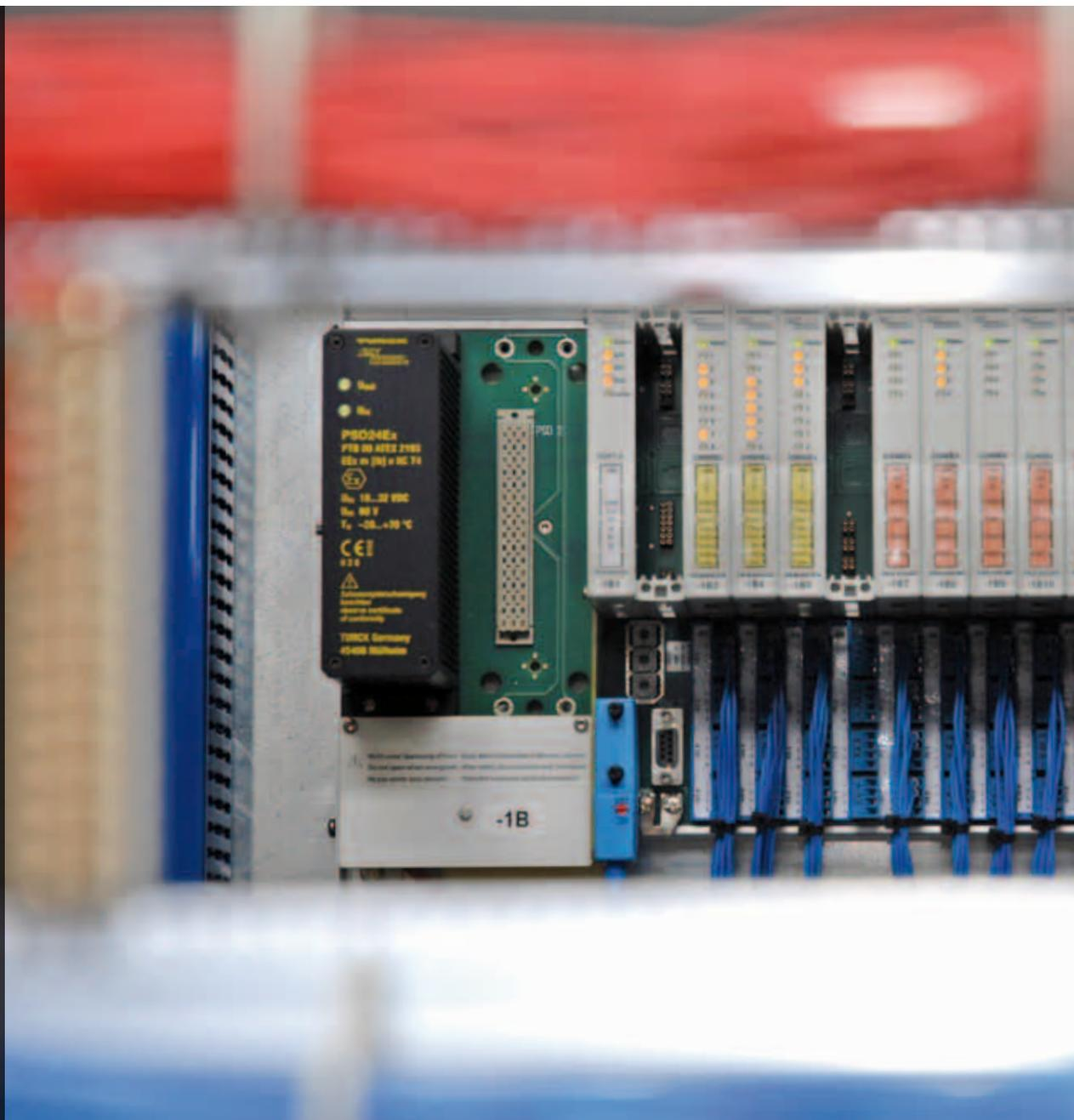
图尔克excom远程I/O系统在非常狭小的空间内提供了128个数字通道或64个模拟通道
