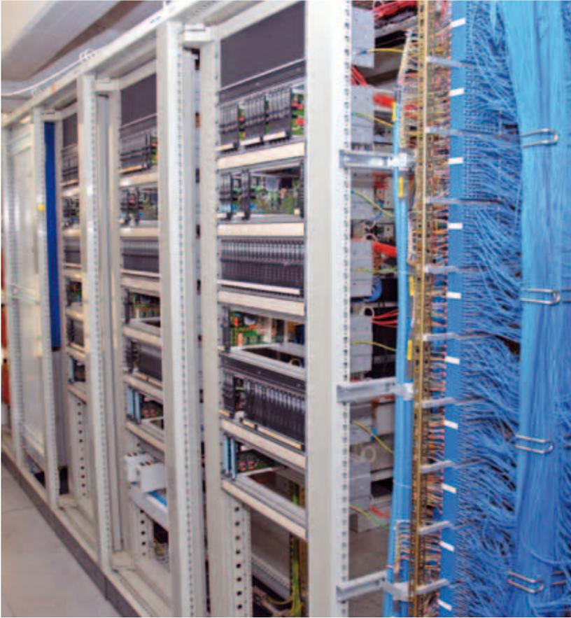
自从对工厂进行现代化改造后，19英寸机架（后排）就不再用于安装接口卡，而是用于容纳两个excom系统
