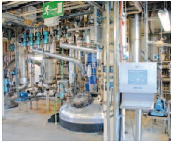
在Elantas的反应器生产线中，众多模拟和数字信号都被从开关室转发给接口卡和excom系统并最终传到控制系统中去
